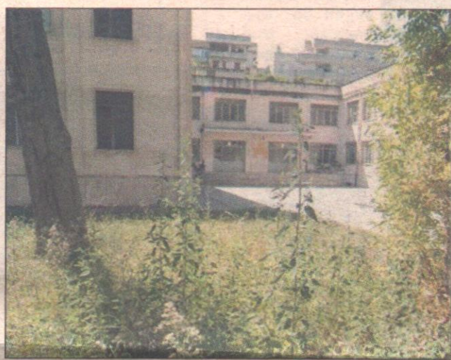
I bambini tornano a scuola ma le strutture nel Comune capoluogo non sembrano pronte ad ospitarli. E' il caso delle elementari "Rodari" ai Cappuccini e "Tempesta" alla Commenda, entrambe coperte di erbacce
