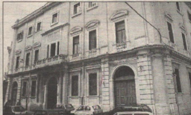
La sede della Provincia di Brindisi
