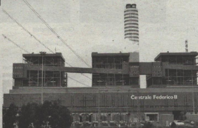
La centrale Enel "Federico II"
