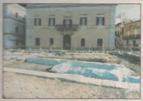
Il cantiere sul lungomare A pag. 14
