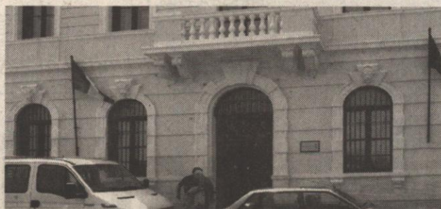
La sede di Brindisi LNG
