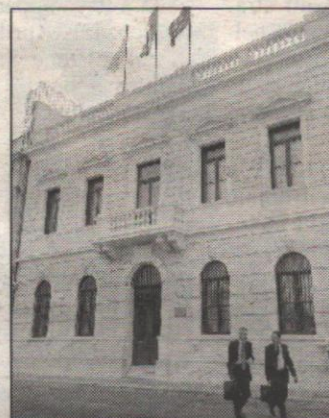
La sede della Brindisi Lng
