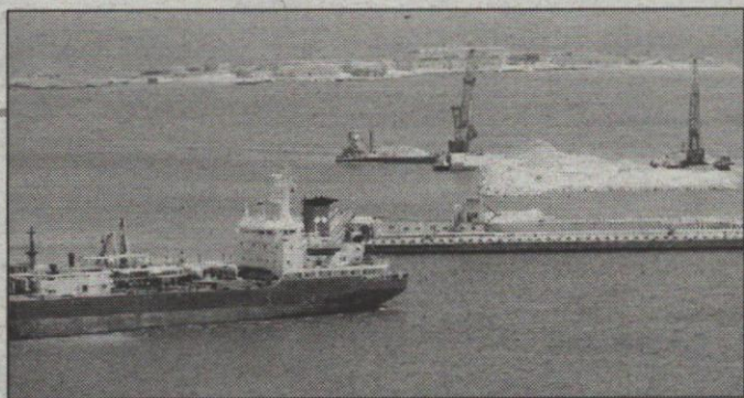
Un'altra immagine degli interventi della Lng
