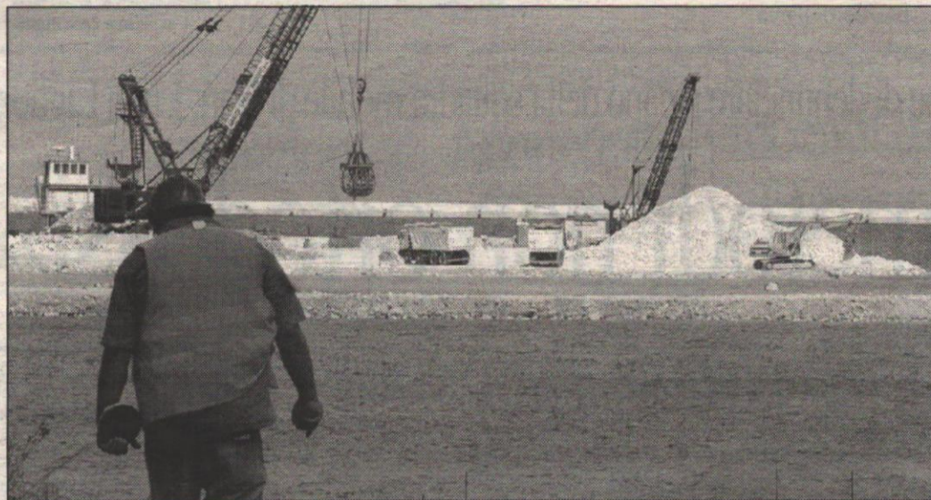
Lavori per la costruzione del rigassificatore a Brindisi
